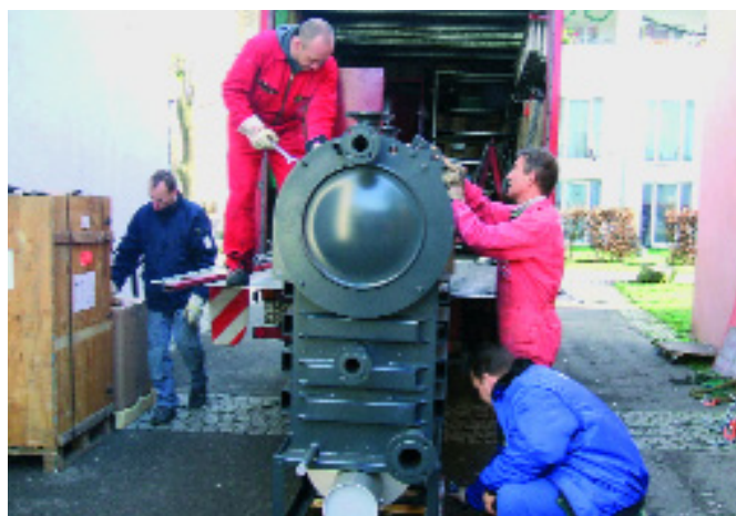
Ein Arbeitsbeispiel der größeren Art im Bereich der laufenden Instandhaltung: Hier musste in der kalten Jahreszeit ein defekter Heizkessel ausgetauscht werden.
