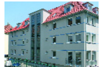
Das Bülowhaus kurz vor seiner Fertigstellung
